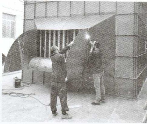
※ 9月下旬，新购置的大家伙——LZD-50型静电回收装置已经从生产厂家运抵公司，安装人员正在紧锣密鼓的施工，争取尽早投入使用，替代原来老旧的装置，提高废气收集效率。
